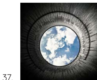
Tour de refroidissement, centrale nucléaire de Gösgen, Däniken (SO)
