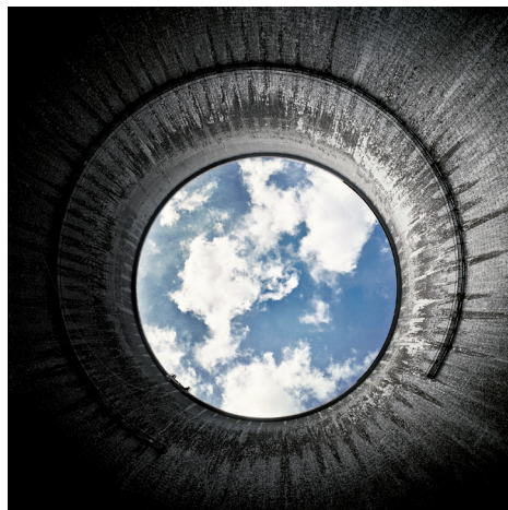
Tour de refroidissement, centrale nucléaire de Gösgen, Däniken (SO)
